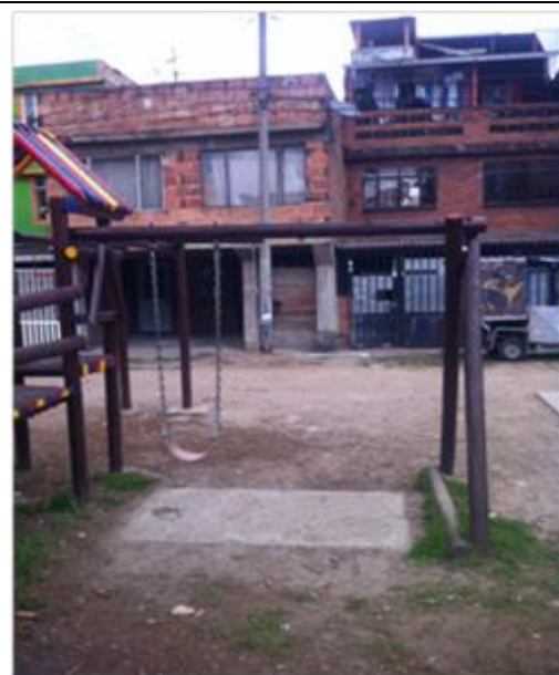
Foto 6. El terreno presenta falencias en el parque infantil, lo cual puede ser un peligro para los niños, falta la cadena galvanizada incluyendo el columpio.
