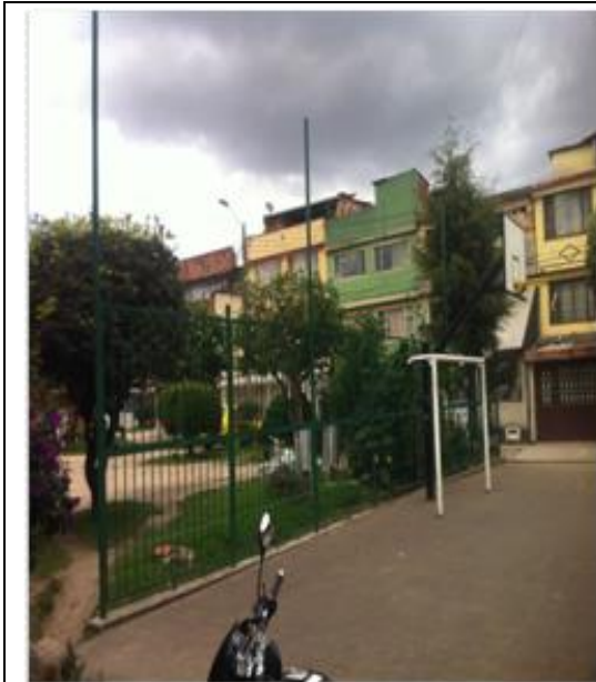
Foto 9. No se encuentra terminada la malla contra impacto en la parte superior
